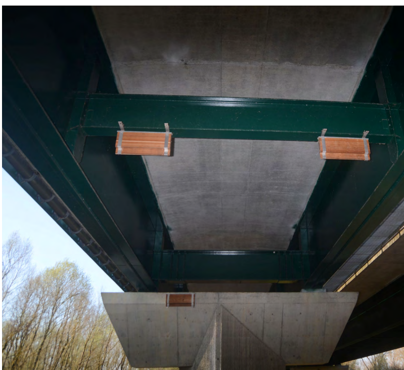
Figure 3. Plusieurs gîtes occupés sous le pont de la commune de Farges-Allichamps © L. Arthur
