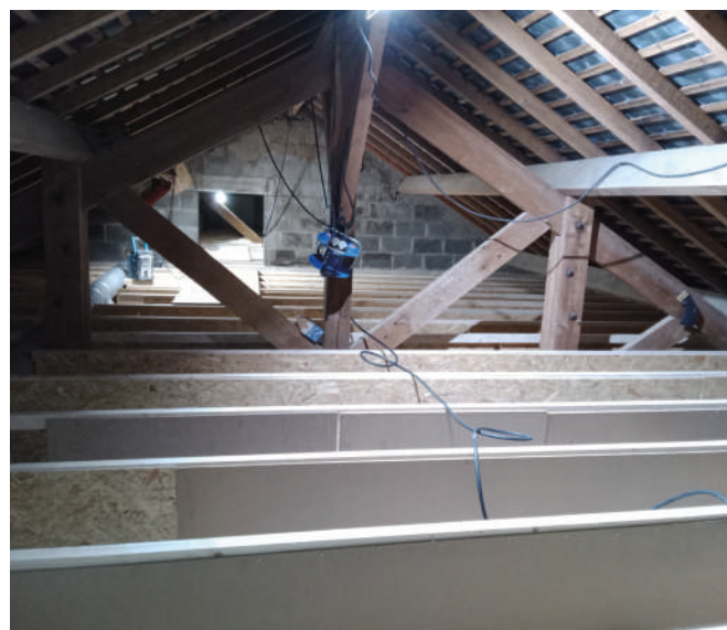
Étapes 1 (au dessus) et 2 (au dessous, pose du plancher en cours)
