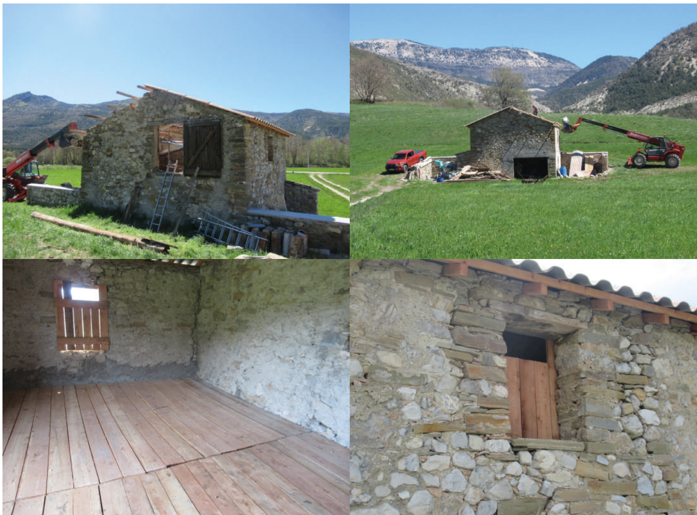
Figure 3. Travaux sur le bâtiment et installation de chiroptères.
