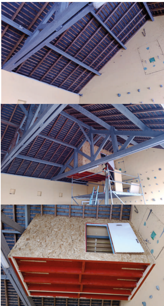
Étape 4. Avant, pendant et après la réalisation du caisson isolé. La porte sur le mur jaune constitue l'accès humain vers le comble occupé par la colonie.
